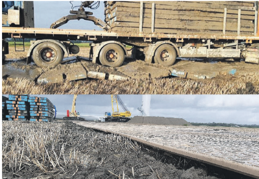
Een bouwweg in de Wieringerwerf. Wegzakkende draglineschotten zijn vervangen door Ferex rijplaten.
