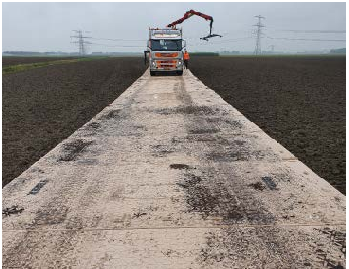
De lichtgewicht Ferexrijplaten zijn innovatieve vervangers voor de traditionele stalen rijplaten en draglineschotten.
